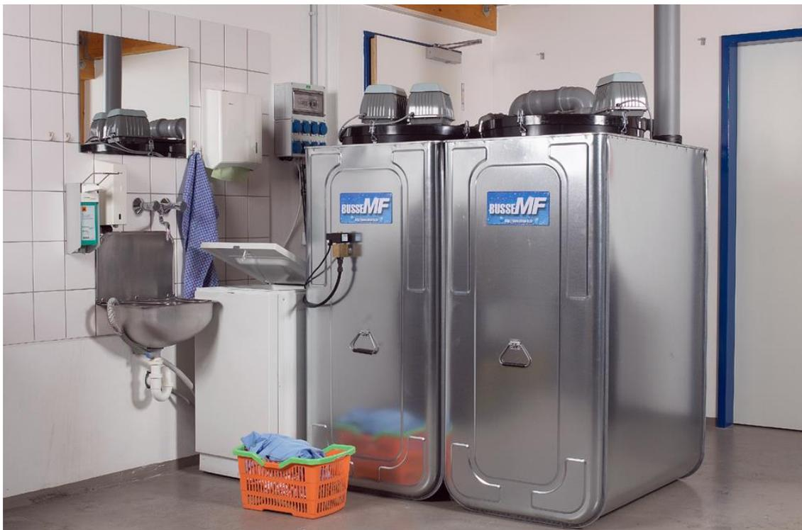
Abb. 3: Aufstellung BUSSE-MF Typ MF-HKA4 im Keller
